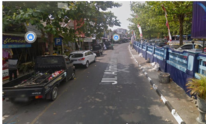
Gambar 11. Kondisi trotoar di Jalan Ahmad Jazuli.
